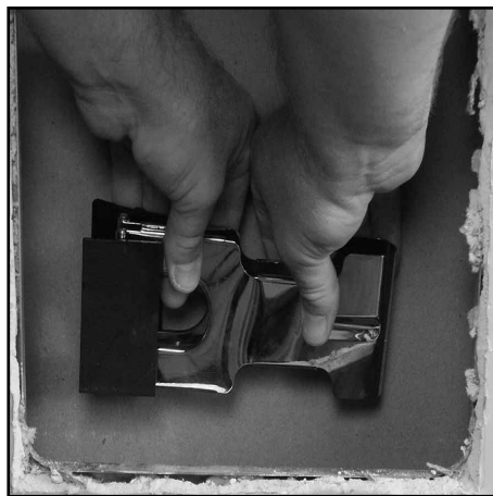
The patent-pending UltraDamped Mounting System includes both insulation and the unique WallBracers which act together to reduce the distortion caused by drywall resonance. / Le système brevet-en suspens de support d'UltraDamped inclut l'isolation et le WallBracers unique qui agissent ensemble de réduire la déformation provoquée par résonance de plaques de plâtre.
