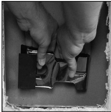
The patent-pending UltraDamped Mounting System includes both insulation and the unique WallBracers which act together to reduce the distortion caused by drywall resonance. / Le système breveté en suspens de support d'UltraDamped inclut l'isolation et le WallBracers unique qui agissent ensemble de réduire la déformation provoquée par résonance de plaques de plâtre.
